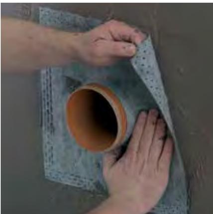
Рис. 2: ADF<sup>®</sup>-Rohrmanschette
