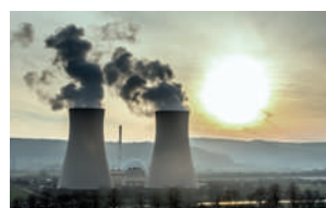
Elektros jėgainių aušinimo bokštai
